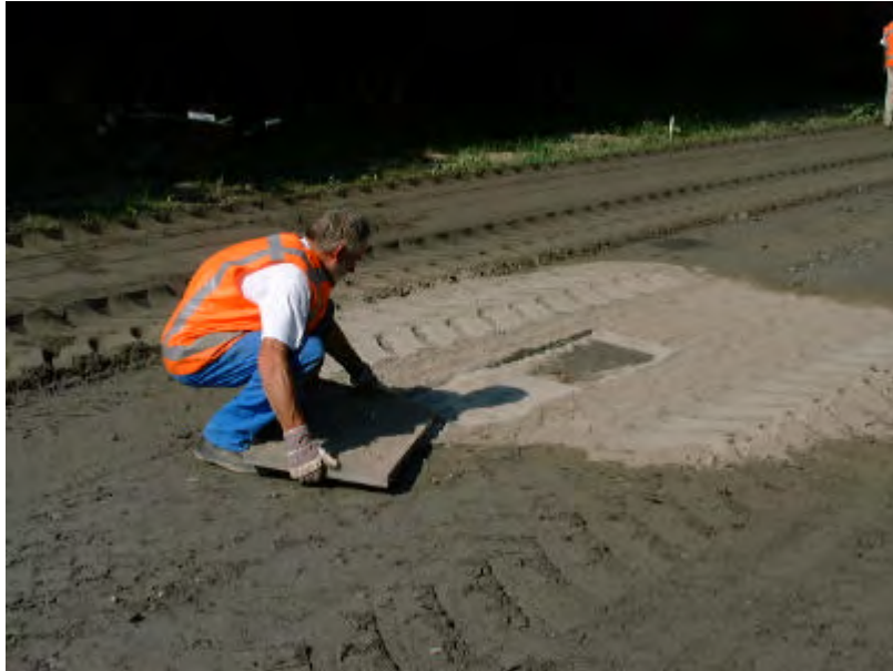
Foto 6: Bepaling cementgehalte met de doseerplaat.
